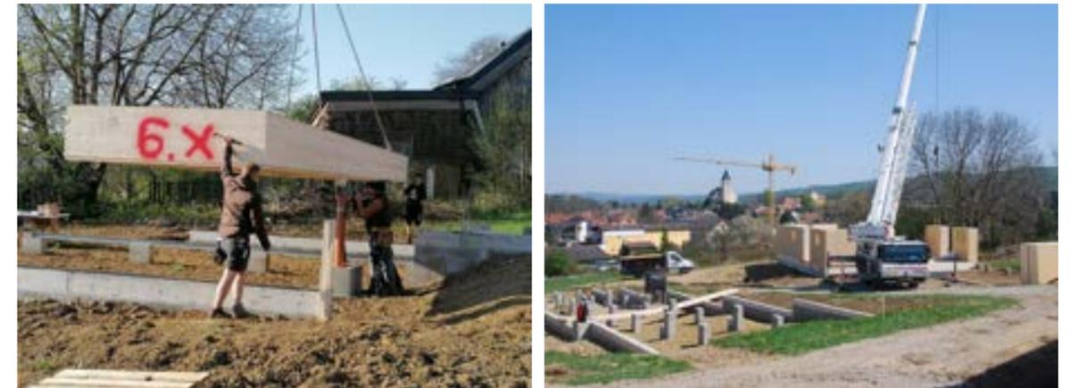
Versetzen des ersten Bodenelements und einfädeln der Leitungen aus dem Installationsschacht; Blick über die gesamte Baustelle mit Kran und bereits an diesem Tag bereits versetzten und montierten Boden- und Außenwandelementen des ersten Teils des Doppelhauses (Top 10).
