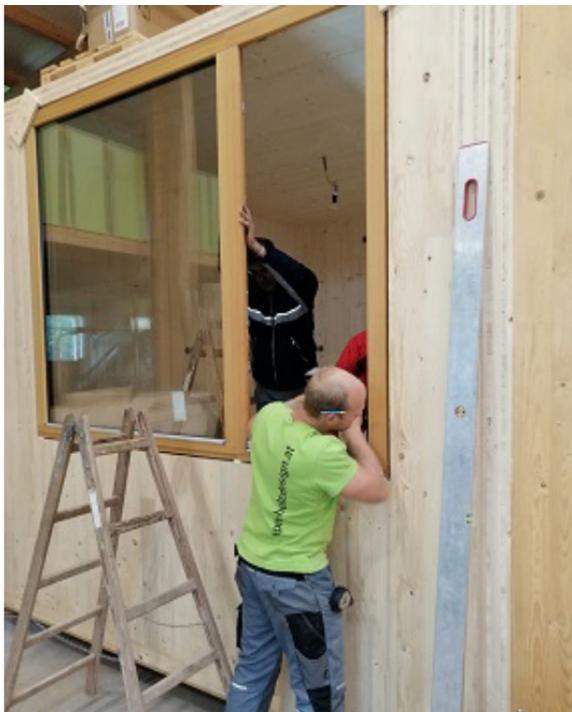
Innenausbau Tischlerarbeiten von links oben nach rechts unten: Montage der modularen Deckenpaneele für die Unterdecke, Einbau der Zargen für die Innentüren, der Einbau aller Fenster und auch der Haustüren erfolgen bereits im Werk.
