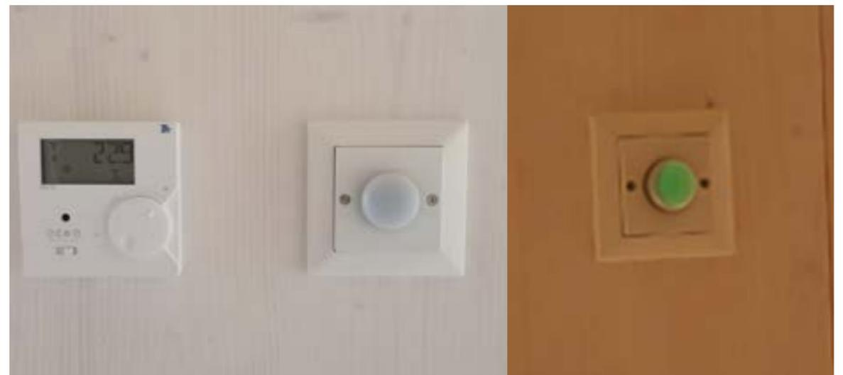
Alle Wohneinheiten sind mit Raumsensoren und einer Energieampel ausgestattet. Die Energieampel zeigt grün an, wenn ein Überschuss an Eigenproduktion Strom vorhanden ist (PV + Enertwin)
