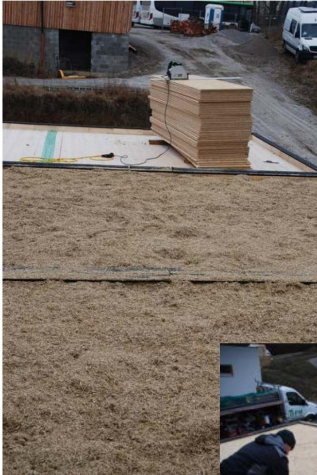
Für den Schallschutz und die Dämmung zwischen den Geschoßen wird eine Schicht Iso-Stroh lose als Schüttdämmung eingebracht und mit OSB-Platten abgedeckt. Darauf werden dann die Module des Obergeschosses gestellt.
