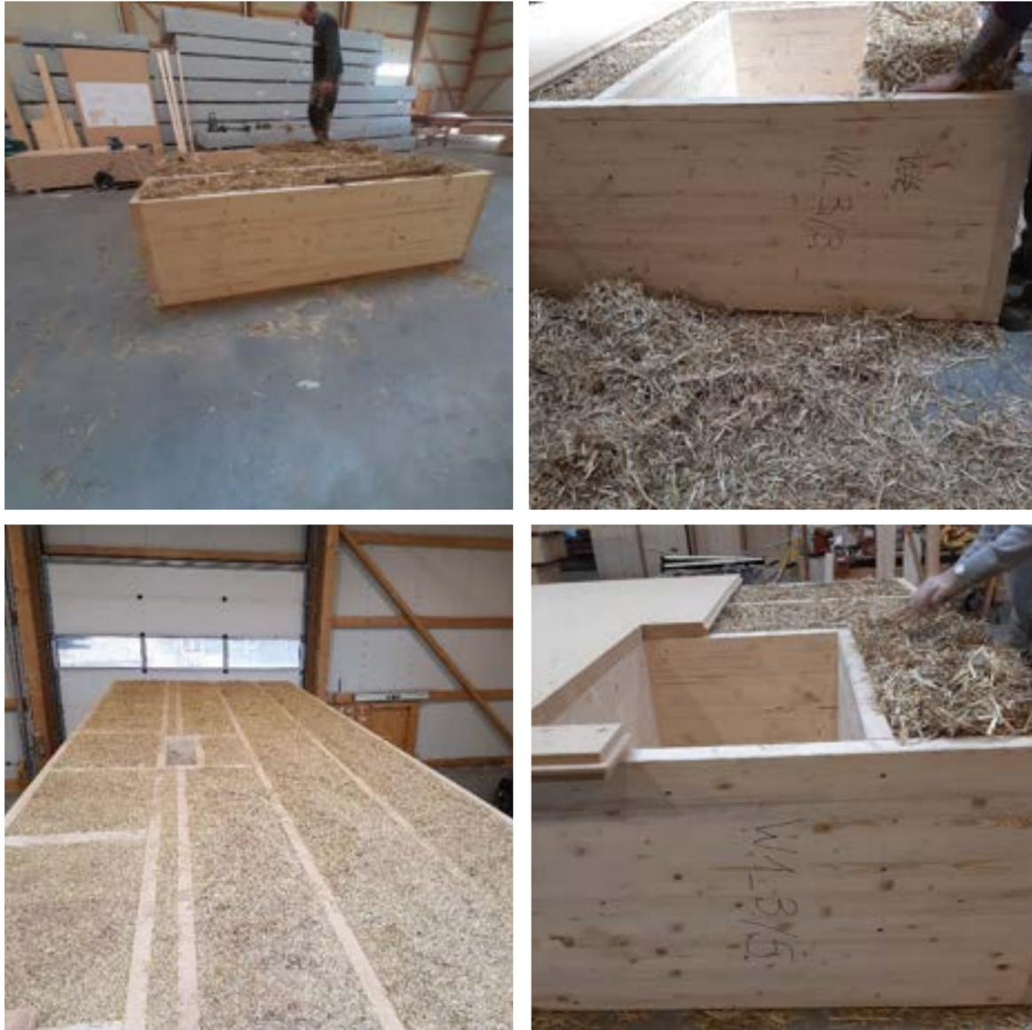
Außenwandaufbau: Die Großstrohballe werden bereits im Werk komprimiert in die BSH-Rahmen (Brettschichtholz) mit Rippen (als Setzungsbegrenzung und statische Unterstützung bei der Lastabtragung) eingebracht. Die Elemente werden an der Außenseite mit einer Weichfaserplatte (als Putzträger) und innen mit OSB als Dampfbremse beplankt. So entsteht ein teillasttragender Strohandaufbau verbunden mit dem Vorteil der Vorfertigung im Werk.
