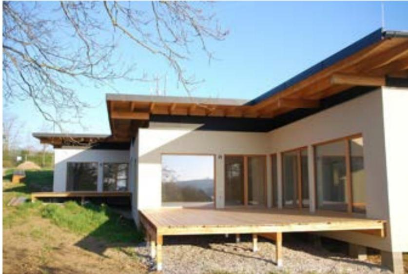
Die großzügigen Terrassen des Doppelhauses stehen auf Schraubfundamenten und werden ebenfalls in Lärche ausgeführt. Alle Fenster haben Passivhausstandard und sind mit Holzrahmen ausgeführt.
