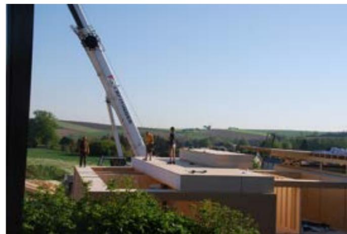
Nach der Montage der Überlager werden die Deckenelemente versetzt und montiert. Aufgrund der Vorfertigung und der Passgenauigkeit der einzelnen Elemente konnte eine Wohneinheit (ein Atriumhaus) innerhalb einer Woche inkl. Dachaufbau aufgestellt werden.
