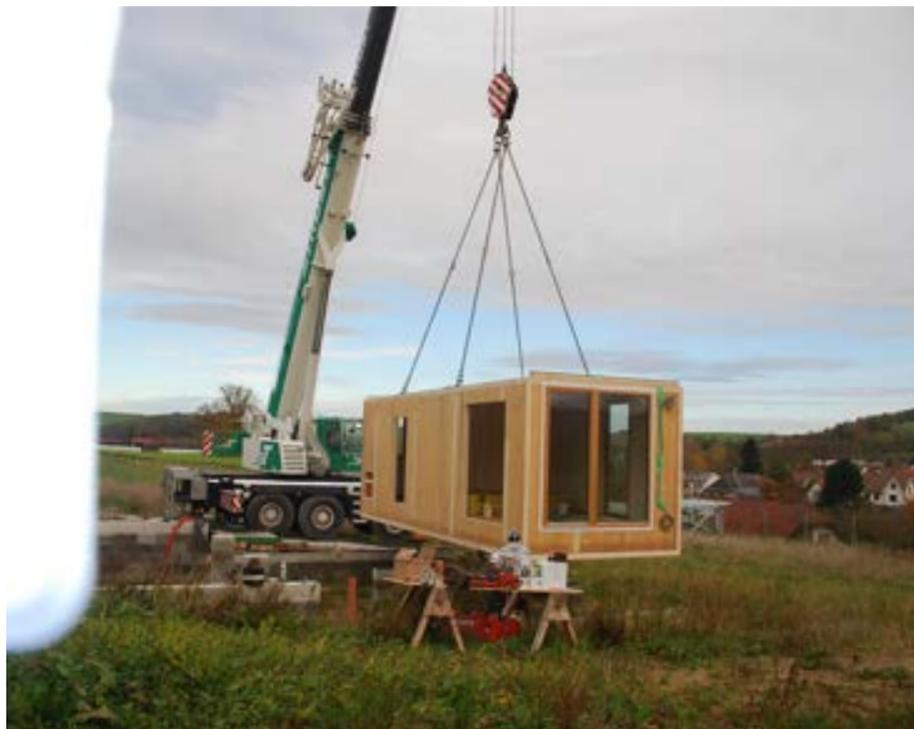
••• Das erste Modul (Top 7 Wohnmodul) wird mit dem Kran auf die Fundamente gehoben und präzise ausgerichtet.
