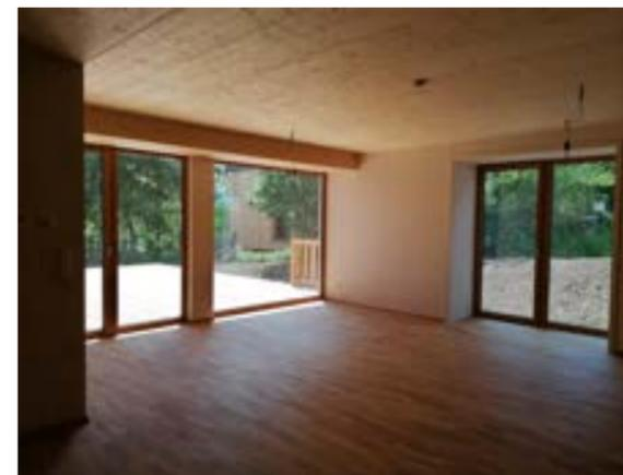
Über den Aufbau der Fußbodenheizung kommt eine Unterlage aus Kork und darauf ein schwimmend verlegter Parkettboden. Der Verzicht auf Klebstoffe sorgt für ein gesundes Raumklima und eine sortenreine Trennung bei Renovierung oder Rückbau.
