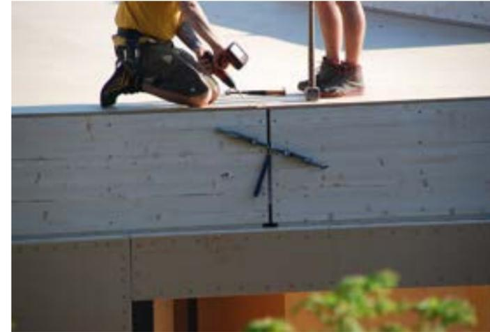
Die Deckenelemente sind von innen nach außen folgendermaßen aufgebaut: OSB Platte; 60 cm Einblasdämmung Strohhäcksel; dazwischen Rippen; feuchteresistente DHF Platte. Nach dem Versetzen werden die Elemente untereinander mit langen Spezialschrauben verbunden.
