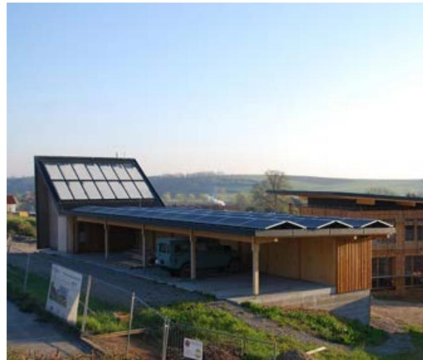
Auf dem Dach des Technikraums (Steildach im Hintergrund) befindet sich die Solarthermie-Anlage mit einer Bruttogesamtfläche von 33,4 m<sup>2</sup>. Am Dach des Carports sind drei Reihen PV-Module angebracht in Ost-West-Ausrichtung mit einer Gesamtleistung von 23,76 kWp, die PV-Anlage ist als Gemeinschaftsanlage eingerichtet und versorgt auch die Wohneinheiten mit Energie.
