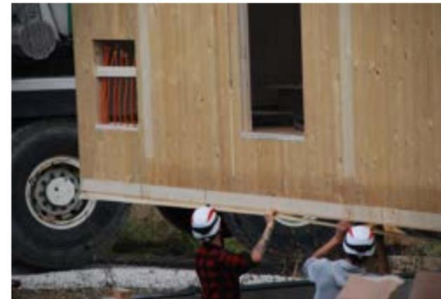
Die einzelnen Module werden um Luftdichtheit zu gewährleisten stoßverklebt und mit den Einzel- und Streifenfundamenten fest verschraubt.
