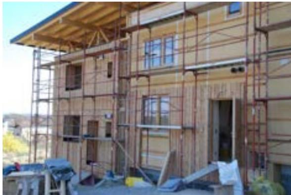
Die hinterlüftete Holzfassade (senkrechte Boden-Deckel-Schalung aus Lärche sägerau) wird an der Konterlattung der Außenwand montiert und die ebenfalls in Holz ausgeführten Terrassen, Balkone und Hauszugänge installiert. Währenddessen wird die Innenausstattung des Treppenhauses und des Gemeinschaftszentrums ebenfalls fertig gestellt.
