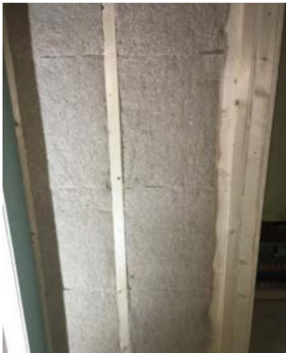
Innenwände bestehend aus einer Holzständerkonstruktion und 3-Schicht-Platten Fichte werden aufgestellt und mit einer Gefachdämmung aus Hanfdämmmatten gefüllt. Bild unten rechts: Die flexiblen Trennwände werden erst nach der Bodenverlegung installiert um im Falle einer Verschiebung oder der Entfernung der Zwischenwand einen durchgehenden Bodenbelag zu gewährleisten. Zum Abschluss werden die Innenwände mit naturbelassener und lösungsmittelfreier weißer Leinöllasur gestrichen.
