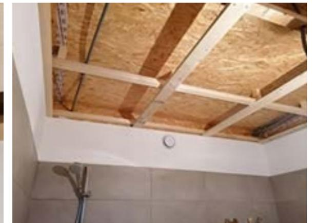
Unterkonstruktion für die abgehängte Innendecke in den Räumen; im Zwischenraum zur obersten Geschoßdecke ist genügend Platz für die Leitungsführung und Haustechnikkomponenten (z.B. Lüftungsgerät). Die Sichtdecke wird mit einzelnen, geschraubten Paneelen aus Fichte ausgeführt, das ermöglicht einen einfachen Wartungszugang, aber auch z.B. den Lichtauslass bei Bedarf einfach zu versetzen
