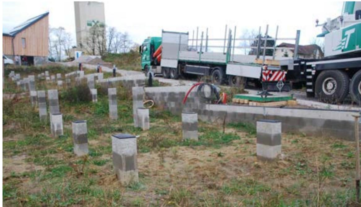
••• Vorbereitung der Fundamente für die Auflage der Module mit Auflagepads aus Gummigranulat (Feuchte- und Reibungsschutz Holzbau), die Metallverbinder zum Verschrauben der Module mit den Fundamenten wurden ebenfalls bereits an den Fundamenten vormontiert.
