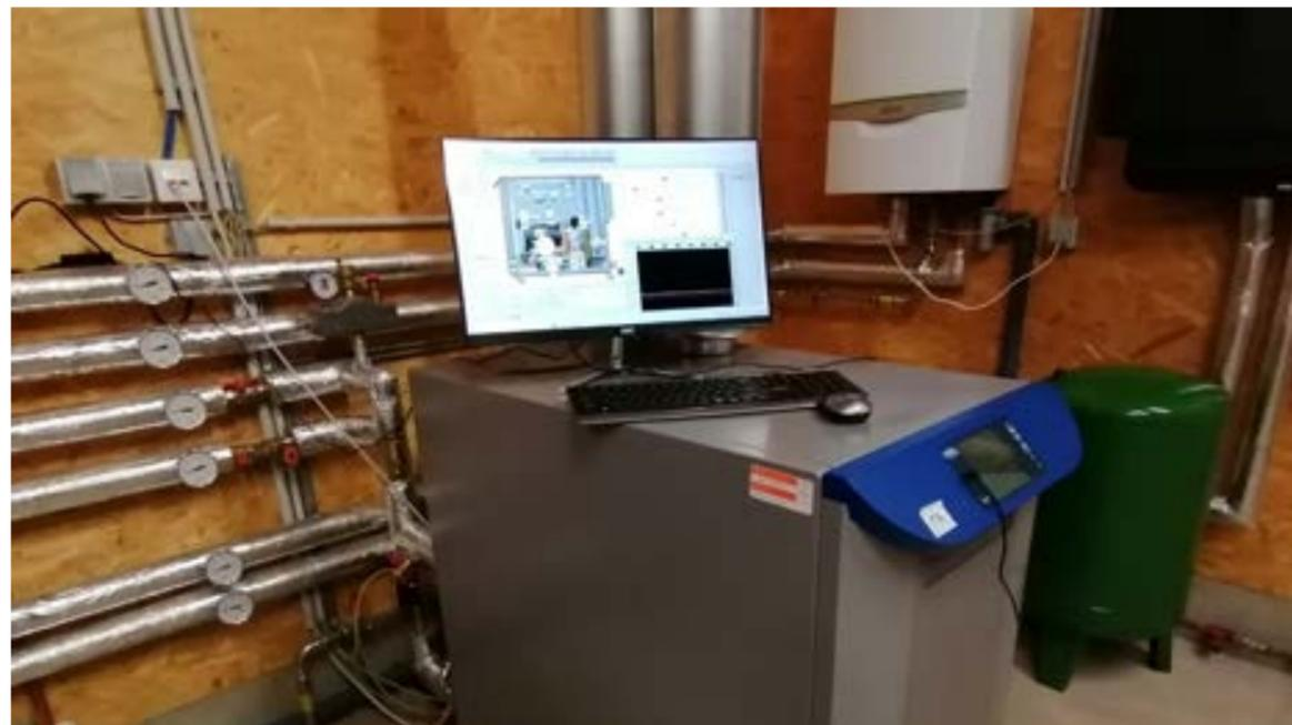
Die Enerboxen (WW-Wandspeicher-systeme) in den einzelnen WEH werden zentral drei Mal täglich aus dem 5000 l Pufferspeicher im Technikraum beladen. Dieser wiederum wird von der Solarthermie Anlage und dem Mikro-KWK mit Warmwasser beschickt.
