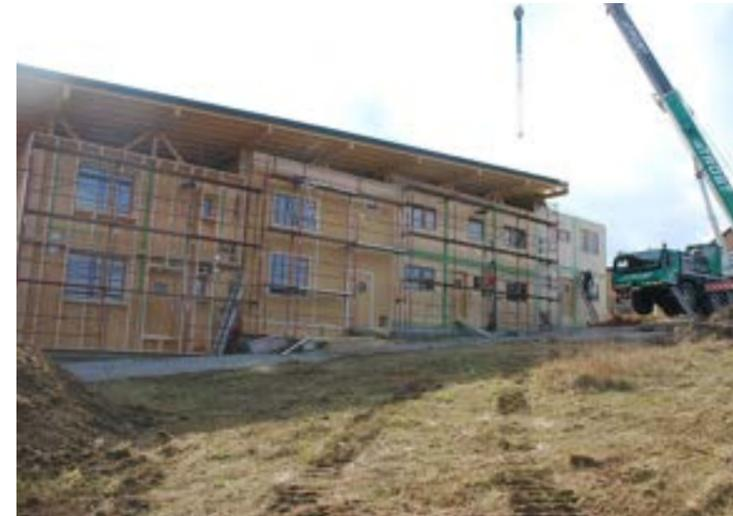
4. Bauabschnitt: Versetzen und Montage Top 1 + 2 (Reihenhäuser 2-geschoßig), bestehend aus insgesamt 8 Modulen. Parallel dazu wird im ersten und zweiten Bauabschnitt bereits mit den Arbeiten an der AW-Dämmung und Fassade begonnen.
