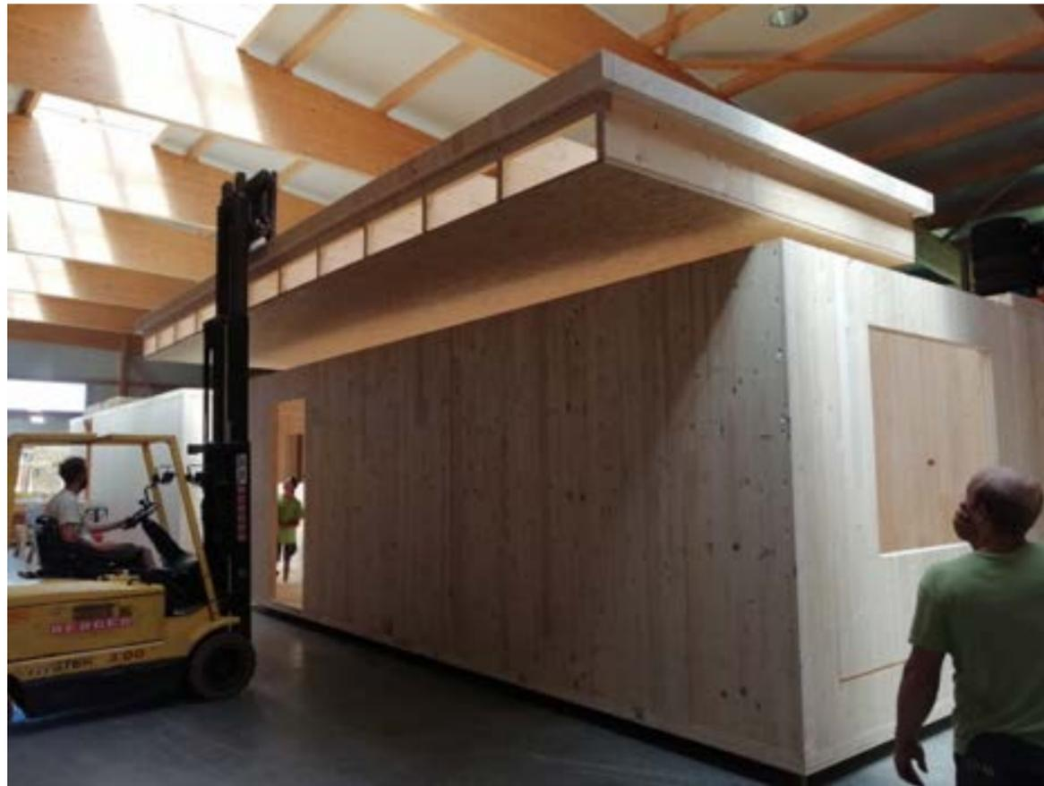
••• Auflage der obersten Geschosßdecke für ein OG-Modul im Werk in Kasten noch ohne Strohdämmung, diese wird nach Montage der Holzkonstruktion direkt eingebracht und danach mit HDF-Platten verschlossen .
