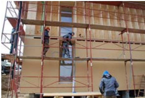
Direkt an die Außenwand der Module wird rund um das Gebäude vor Ort die Holzkonstruktion (Gefach für Einblasdämmung) angebracht.
