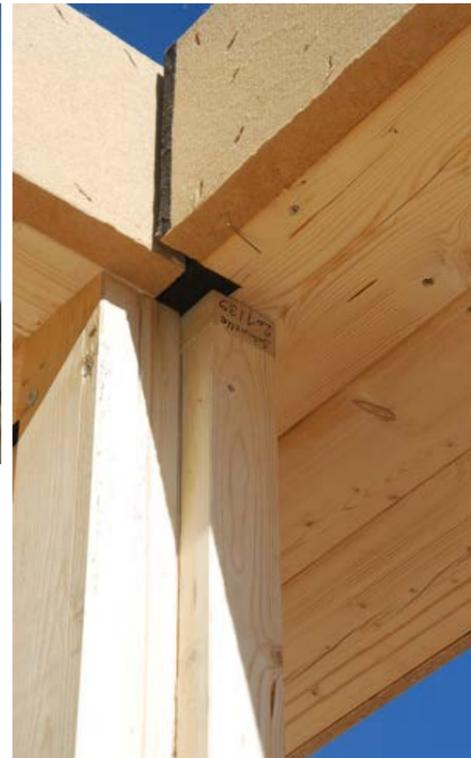
Richtung Süden und Osten verfügen die Wohneinheiten über großzügige Fensterfronten. Bild oben: Auflegen der ebenfalls mit Einblasdämmung Stroh gedämmten Überlagers. Bild rechts: Detailansicht Stoß der beiden Überlager.
