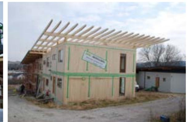
In den Tagen darauf wird der Dachaufbau für das Flugdach ebenfalls fertig gestellt und das Baugerüst für Arbeiten an der Dämmebene und Fassade um den Gebäudekomplex gezogen. Währenddessen werden die letzten beiden Wohneinheiten an die zentrale Haustechnikversorgung angeschlossen.
