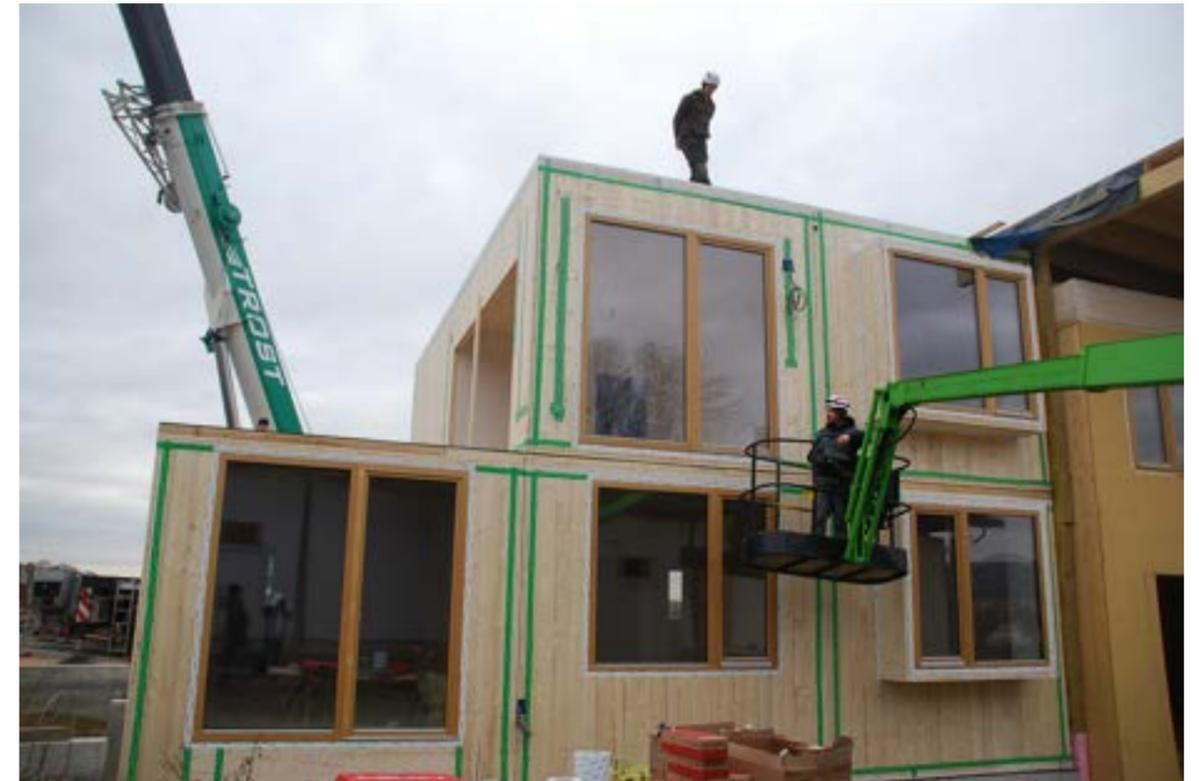
3. Bauabschnitt: Versetzen und Montage der Module für die WEH Top 3 und Top 4 bestehend aus je 2 Wohnmodulen und einem Haustechnikmodul mit einer Wohnfläche von ca. 84 m<sup>2</sup>. Alle Modulstöße und Leitungsfräsungen werden mit speziellen Klebebändern für Holzwerkstoffe luftdicht verschlossen.
