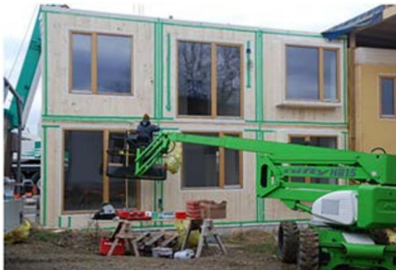
Innerhalb eines Arbeitstages sind auch in Bauabschnitt 3 alle 6 Module versetzt und montiert. Die Module werden horizontal untereinander verschraubt, eine vertikale Verschraubung ist aufgrund der starken Haftreibung der Module zueinander nicht notwendig.
