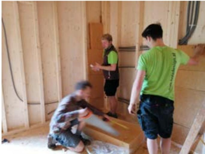
Die elektrischen Leitungen wurden in den Innenwänden verlegt. Die Gefache der Innenwände wurden mit Hanfdämmplatten verfüllt und mit 3-s Platten Fichte verschlossen. Zur Befestigung der Holzplatten wurden innovative Holznägel verwendet. Diese werden mit einem Druckluftnagler ins Holz eingeschossen und durch die entstandene Reibungswärme dehnt sich das Lignin im Holznagel aus, so dass eine unlösbare Verbindung mit dem Werkstoff entsteht.
