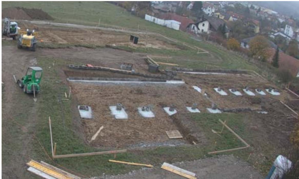
Für die Sockelfundamentewird STB verwendet, die Stützen sind aus bewehrten Schalsteinen mit einer senkrechten Anschlussbewehrung in den Sockel, einer Füllung aus Ortbeton und Abschluss aus STB. Die Schalsteine werden nicht verklebt, da die Betonfüllung für die notwendige Stabilität sorgt.
