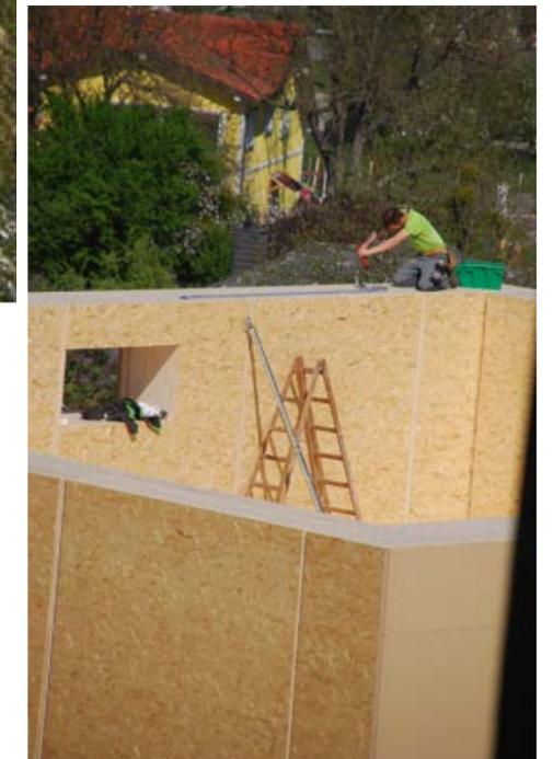
Bild rechts: Die einzelnen Elemente wurden mit Schrauben verbunden und zwischen den Stößen mit Vlies gedämmt. Auf Klebeverbindungen wurde auch hier soweit bauphysikalisch möglich verzichtet. (zB für die Gewährleistung der Luftdichtheit der Gebäude)
