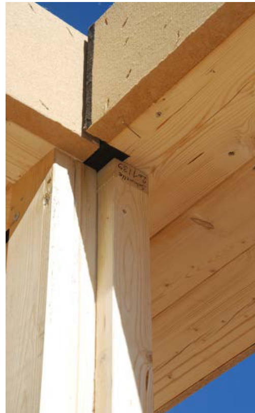
Ansicht der aufgestellten, einseitig bereits vorgefertigten Innenwände, die offenen Gefache (Bild rechts) werden später mit Hanfdämmmatten ausgefüllt und mit 3-Schicht-Platten Fichten geschlossen.
