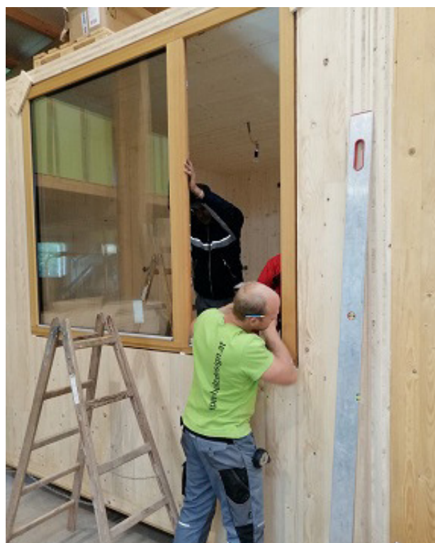
Innenbau Tischlerarbeiten von links oben nach rechts unten: Montage der modularen Deckenpaneele für die Unterdecke, Einbau der Zargen für die Innentüren, der Einbau aller Fenster und auch der Haustüren erfolgen bereits im Werk.
