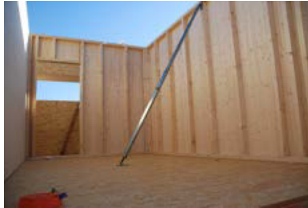
Ansicht der aufgestellten, einseitig bereits vorgefertigten Innenwände, die offenen Gefache (Bild rechts) werden später mit Hanfdämmmatten ausgefüllt und mit 3-Schicht-Platten Fichten geschlossen.
