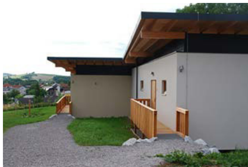
B6: Ansichten des fertig gestellten Doppelhauses. Bild oben: Ansicht Gartenseite von Osten nach Westen; Bild unten: Ansicht Hauszugänge auf der Nordseite (Foto von West nach Ost)
