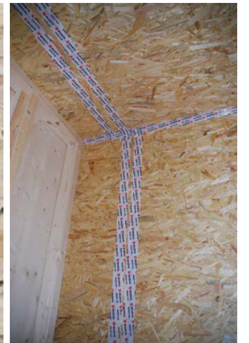
Die Deckenelemente sind von innen nach außen folgendermaßen aufgebaut: OSB Platte; 60 cm Einblasdämmung Strohhäcksel; dazwischen Rippen; feuchteresistente DHF Platte. Nach dem Versetzen werden die Elemente untereinander mit langen Spezialschrauben verbunden.
