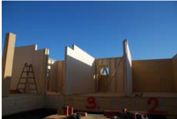
Ansicht der aufgestellten, einseitig bereits vorgefertigten Innenwände, die offenen Gefache (Bild rechts) werden später mit Hanfdämmmatten ausgefüllt und mit 3-Schicht-Platten Fichten geschlossen.
