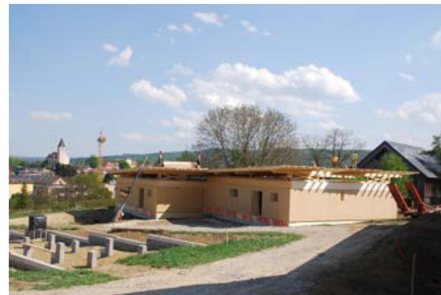
Nordwest-Ansicht Doppelhaus beide Wohneinheiten im Rohbau fertig aufgestellt. Diemit laufenden Arbeiten am Dachstuhl und Flachdach werden gerade ausgeführt.
